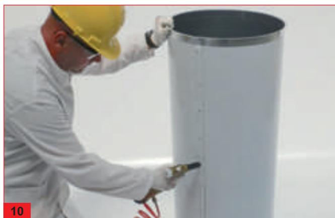
10. Il secondo rivetto sarà quello dell'estremità opposta, il terzo quello al centro e poi gli altri rivetti, per un totale di nove rivetti, posizionati nella parte centrale dell'imbutitura.
