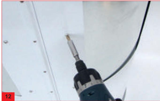
**10-11-12.** Infilare lo sportello facendo attenzione a spingerlo con forza equamente distribuita, per farlo scivolare in modo corretto; evitando che, ruotando su un lato, si impunti. Procedere quindi al completo serraggio delle viti.
